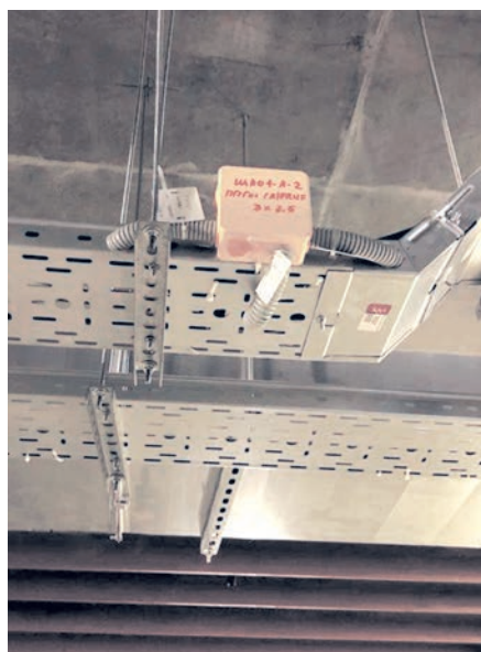
ОКЛ ELTROS OKLine на объекте строительства ЖК «Nagatino i-Land».
