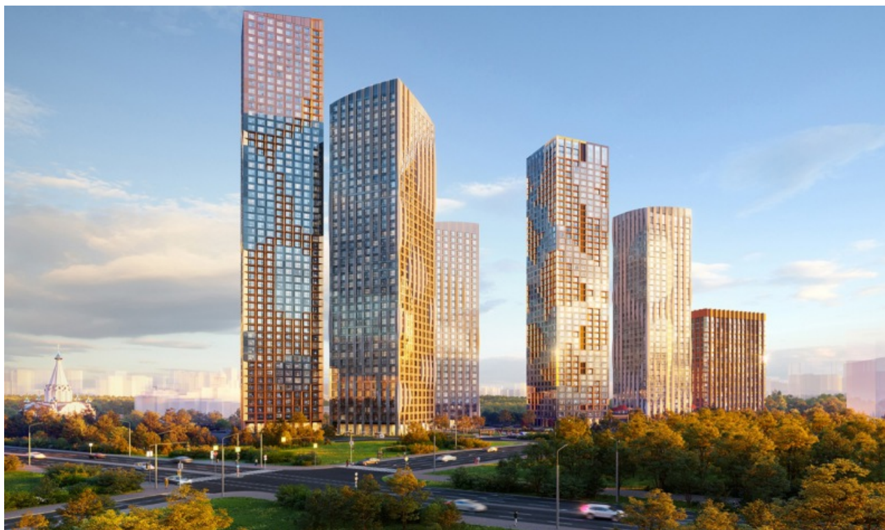
ЖК «Level Мичуринский», г. Москва
