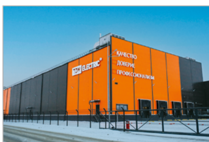
Склад г. Ревда на Урале Класс В, 5-6-ярусное стеллажное хранение.
