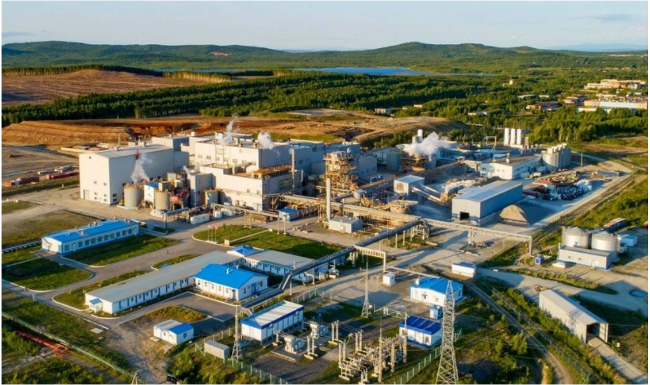
Амурский гидрометаллургический комбинат, г. Амурск
